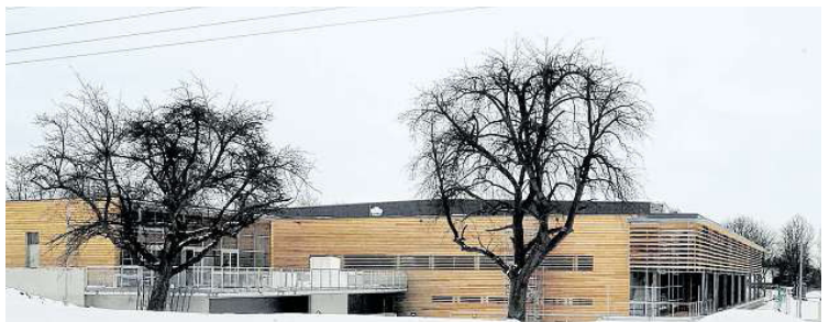
Die Südansicht der Sport- und Schwimmhalle im neuen Sportpark Goldäcker in Leinfelden-Echterdingen zeigt einen langgestreckten Baukörper. Die Fassade hat eine Schalung aus Lärchenholz.
